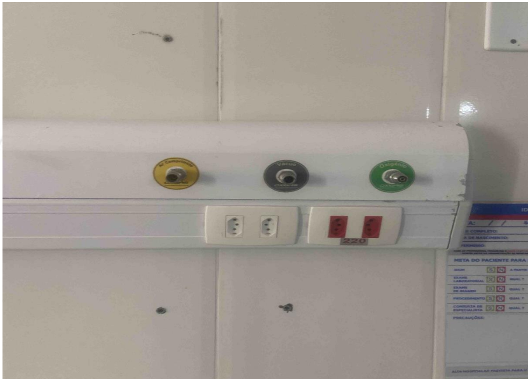
FOTO 275. Conserto do vazamento de O 2 , régua do quarto da CM1
